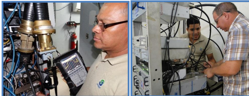
Inspecciones de frecuencias autorizadas, utilizadas para operar servicios de telecomunicaciones, radio y televisión
