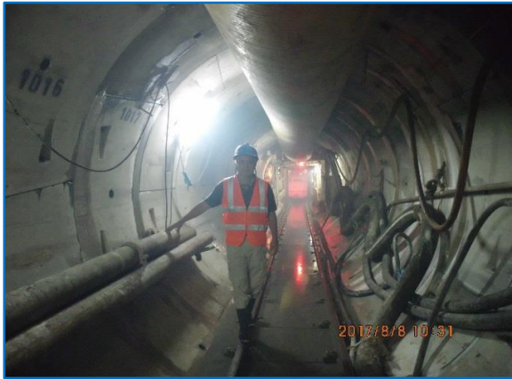
Proyecto Hidroeléctrico Pando - En construcción – 97 % de avance
