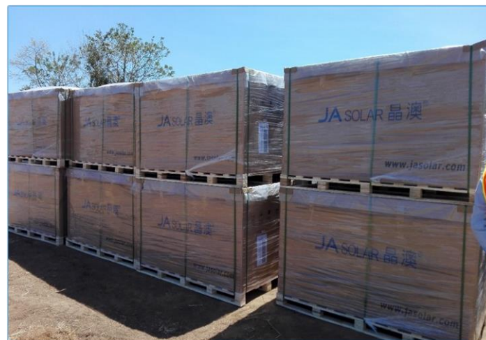
Parque Solar La Estrella (En Construcción-Paneles)
