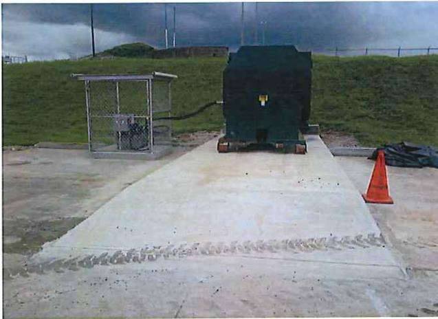
Tanque de compactación de 15 yds.3 y base de concreto y protección
