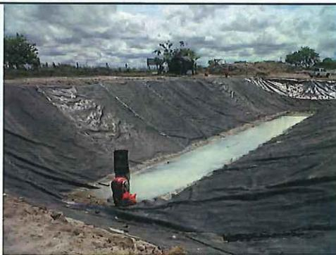
**Trinchera impermeabilizada lista para recibir los residuos sólidos**
