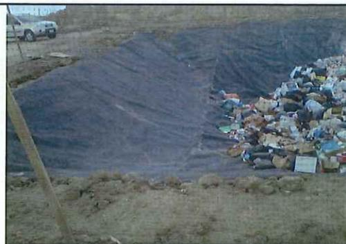
**Colocación de Residuos en la Trinchera para su posterior cobertura.**
