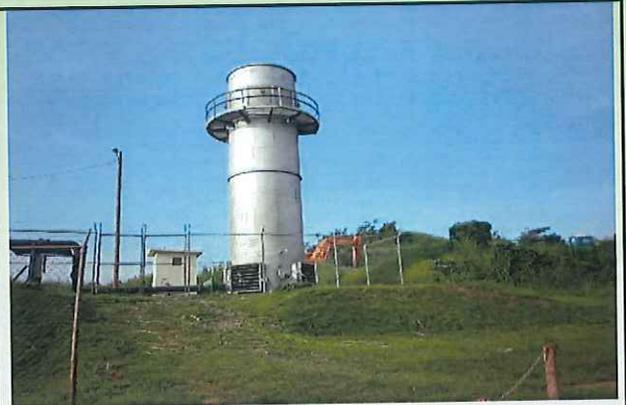
**La antorcha del sistema de quemado de biogás rehabilitada**
