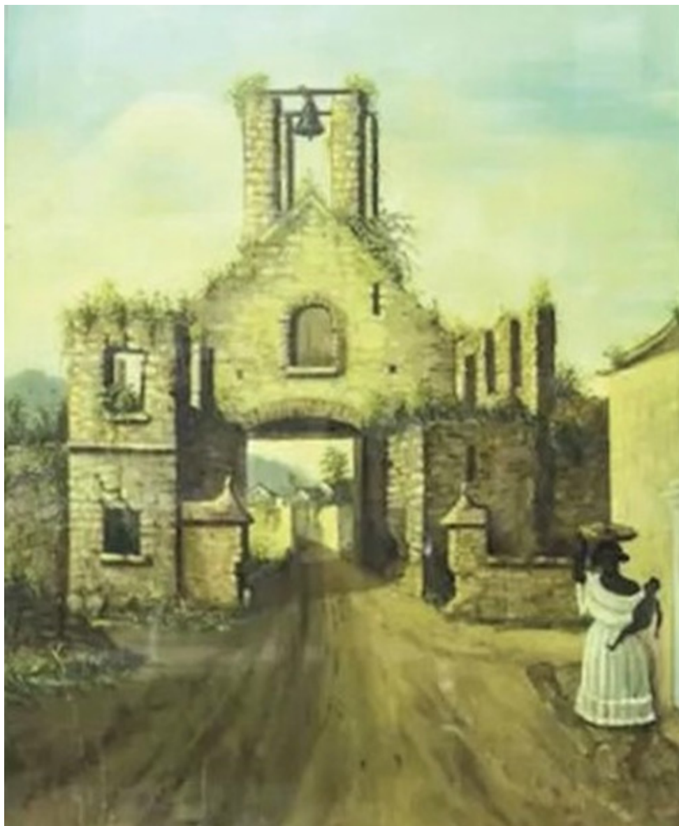
Puerta del arrabal de Santa Ana, que conducía hacia el barrio de San Felipe, estuvo ubicada al frente de la Iglesia de La Merced, donde hoy se encuentra la Mansión Arias Feraud, en la avenida Central - España
