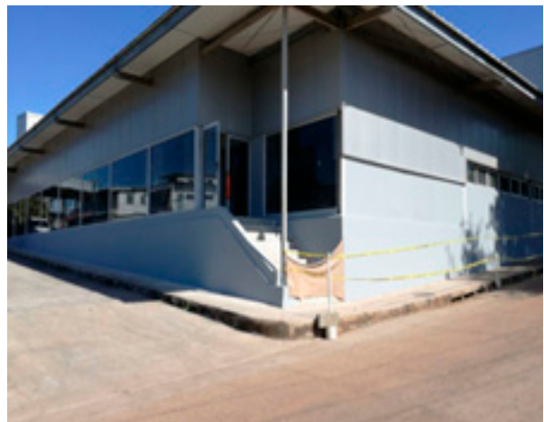
Consulta Externa y Urgencia del Hospital Regional de Chepo.
