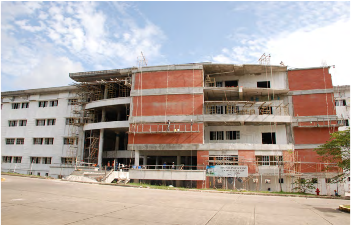
Avances en la construcción del Edificio No. 3
