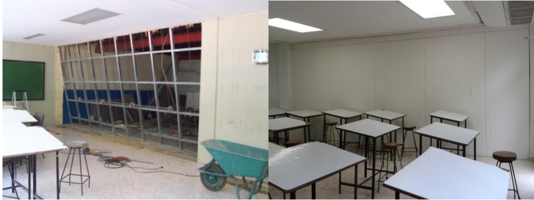
Remodelación de salón de dibujo de la Facultad de Ingeniería Civil, Centro Regional de Chiriquí
