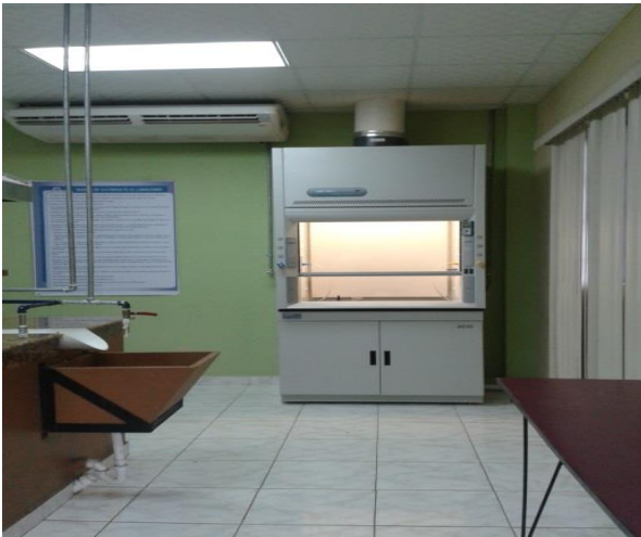
Instalación de Cámaras de Extracción de Gases para los Laboratorios de Química, Centro Regional de Chiriquí
