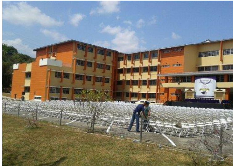
Reforma de la fachada del Edificio No.1 de la UTP
