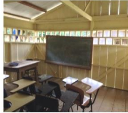
Imagen 27. Reparación de pisos y paredes.
