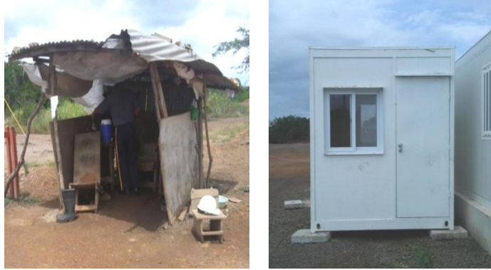
Imagen 2. Antes y después de la caseta de seguridad.
