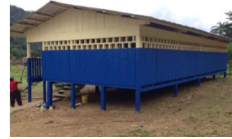
Imagen 28. Acabado de pintura.
