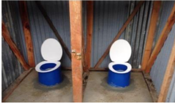
Imagen 26. Construcción de letrina doble.
