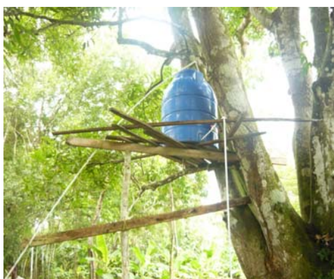
Prueba de altura para la ubicación del tanque de reserva de agua en la finca.
