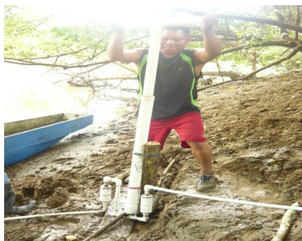
Instalación y prueba de una bomba para el riego de los diferentes cultivos agrícolas.
