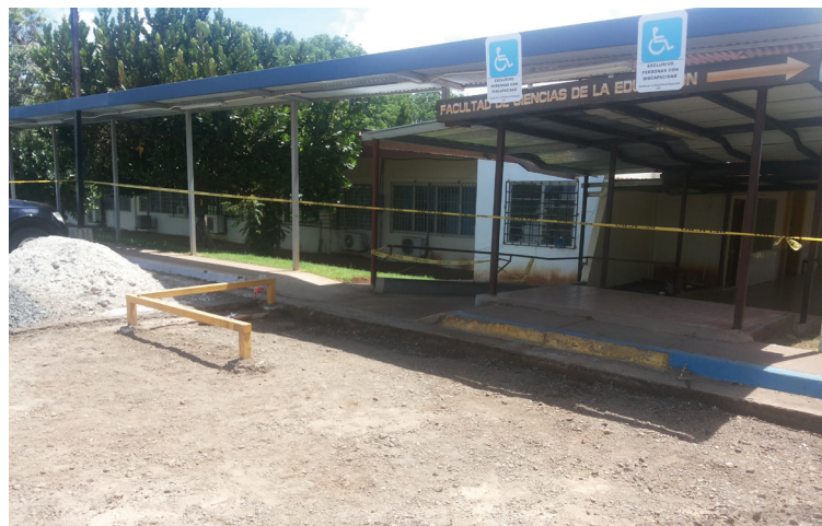
Construcción de rampas para Personas con Discapacidad
