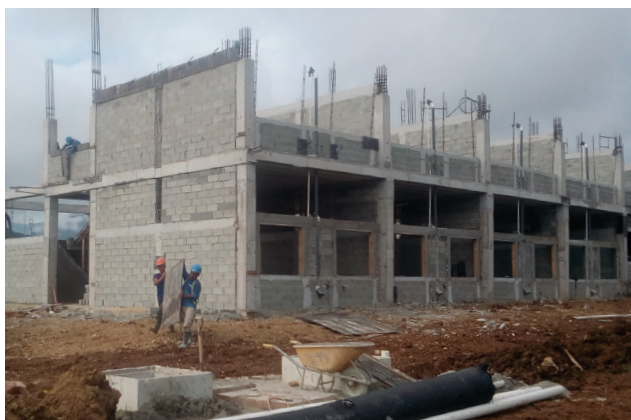
Construcción del edificio de la Extensión Universitaria de Tortí
