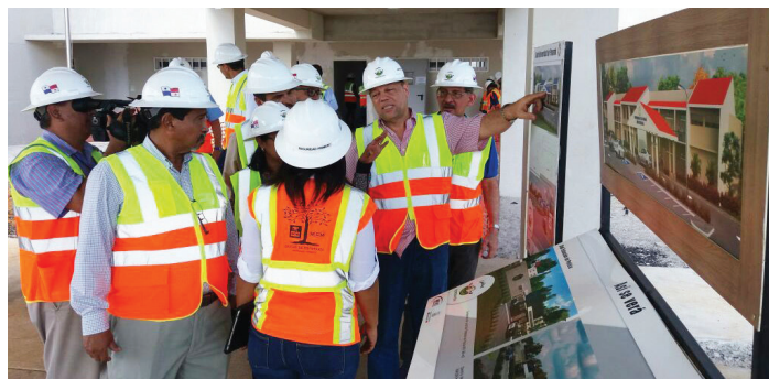
Supervisión de la construcción de la nueva sede de la Extensión Universitaria de Arraiján
