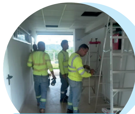
Adecuaciones y reparaciones del cielo raso del edificio de la Extensión, realizadas por parte del personal del consorcio constructor
