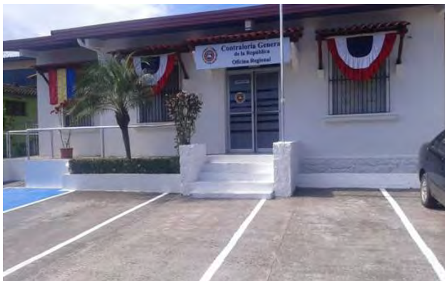
Edificio de La Villa, luego de pintado
