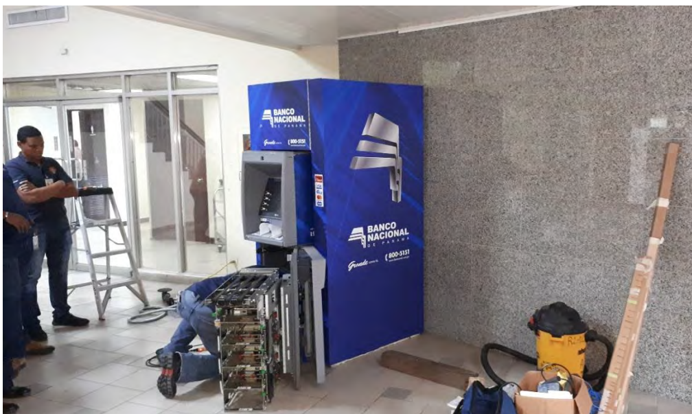
Reubicación de cajero para contar con acceso interno para el pasillo interno peatonal. Septiembre de 2017
