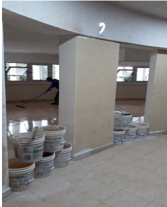
Pulimiento y Adecuación del Piso 2 del Edificio Gusromares, Octubre de 2017
