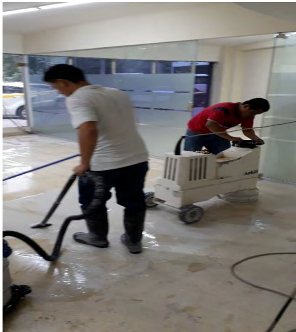
Pulimiento de piso de la Dirección de Denuncia Ciudadana, planta baja del Edificio Gusromares, Octubre de 2017
