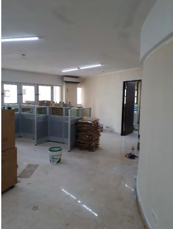
Instalación de Mobiliario en el Piso 3 del Edificio Gusromares, Octubre de 2017
