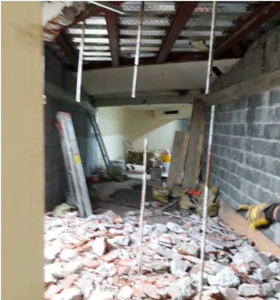
Construcción de Túnel conector entre el Edificio Gusromares y el Edificio Sede, Octubre 2017
