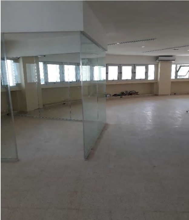
Trabajos de Pulimiento del Piso 7 del Edificio Gusromares, Agosto de 2017
