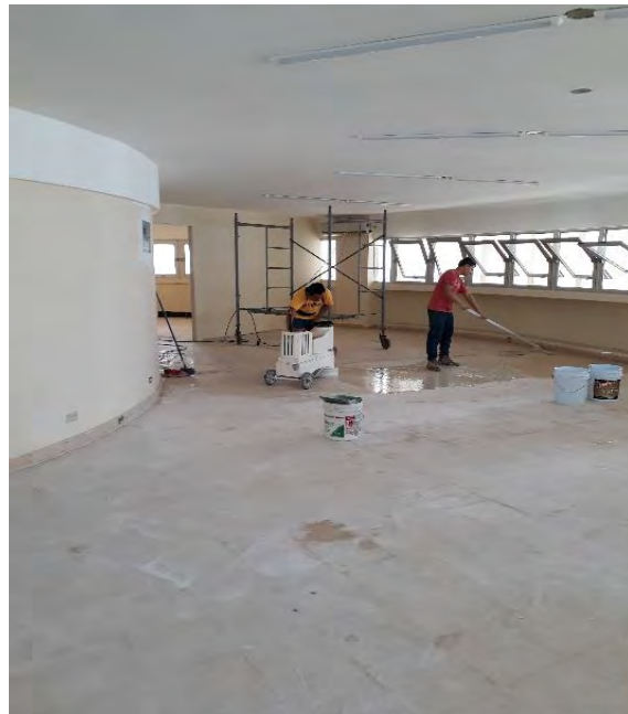
Trabajos de Pulimiento en el Piso 8 del Edificio Gusromares, Agosto de 2017
