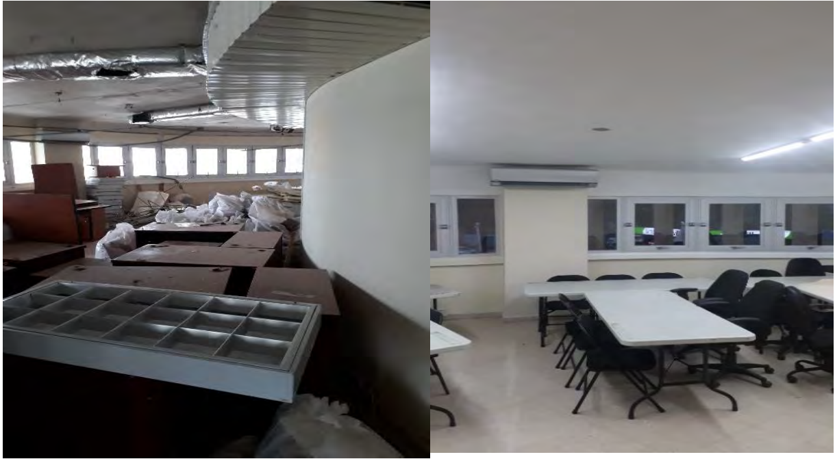
Trabajos de Demolición y Limpieza en el Piso 1 del Edificio Gusromares, Octubre de 2017
