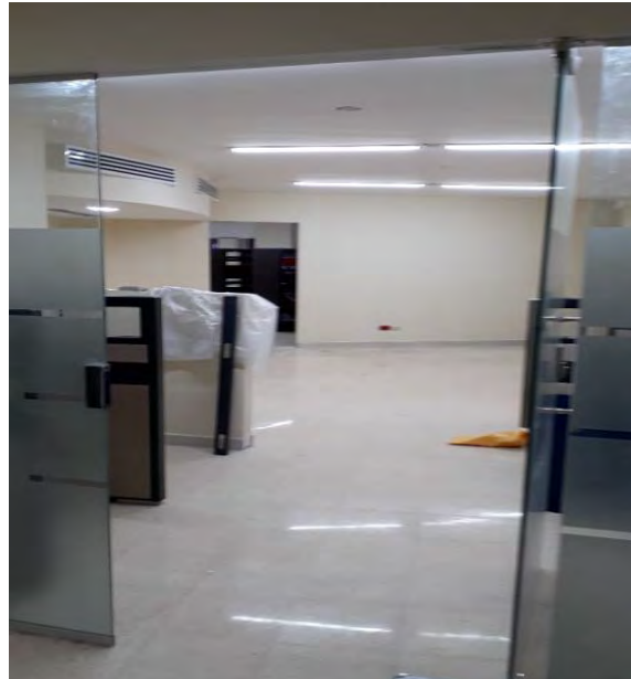
Biblioteca Nueva, Planta Baja del Edificio Gusromares, Octubre 2017
