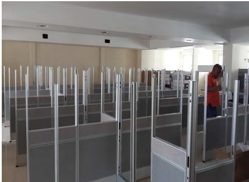
Trabajos de remodelación de la Dirección de Consular Comercial, piso 14, ambas alas. Junio de 2017
