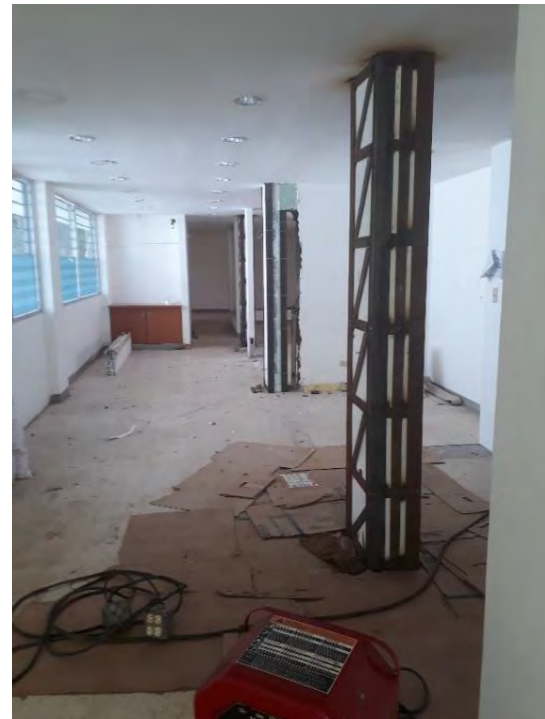
Reforzamiento de Columnas y Estructuras en el Edificio Galicia Trabajos contratados y en ejecución a octubre de 2017
