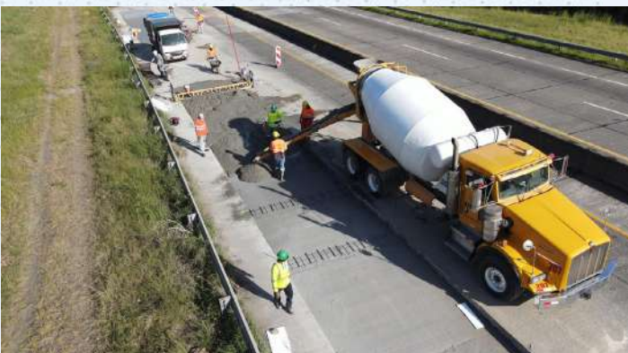
Trabajos de mejoras en el pavimento de los corredores – corredor norte
