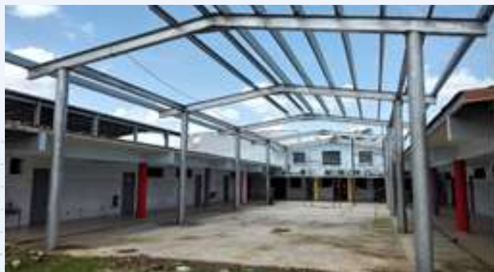
Vista general de la estructura.
