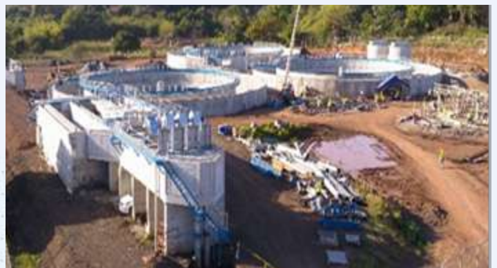
Construcción de Planta de Tratamiento
