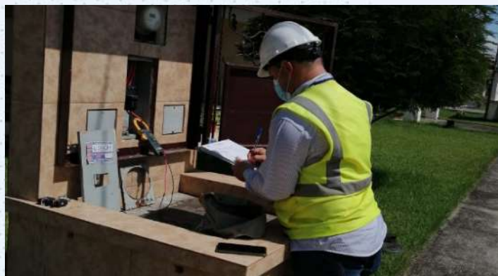
Ejecución de Inspección de reclamo del sector eléctrico.
