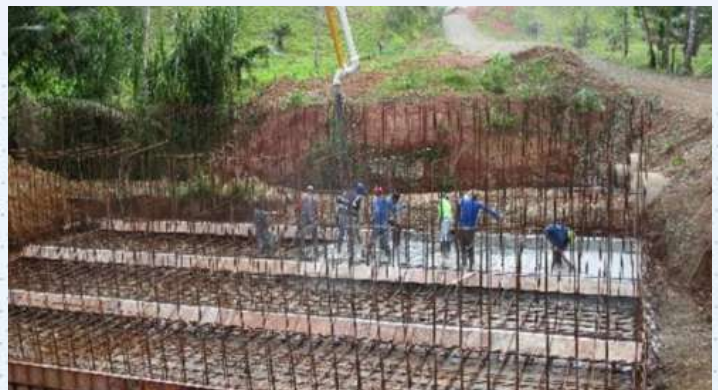
Trabajos en la carretera de Cuango Santa –Isabel
