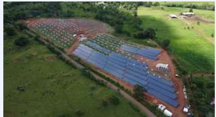
Proyecto Mendoza Solar (3 MW) En construcción
