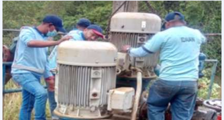
Reparación de estaciones de Bombeo
