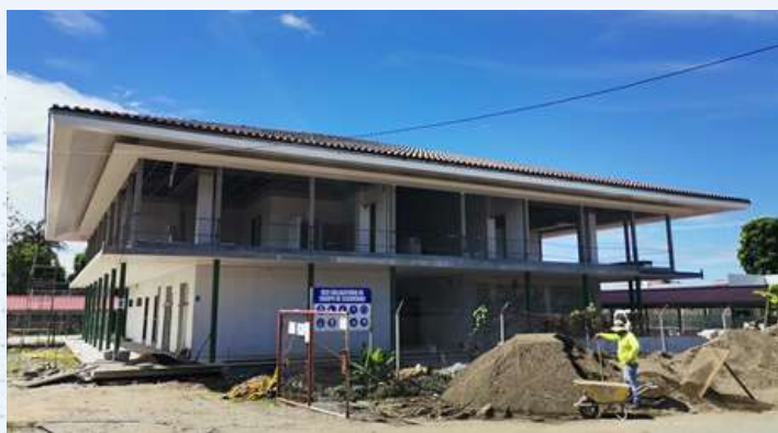
Edificio de Aulas y Laboratorios, Centro Regional de Bocas del Toro
