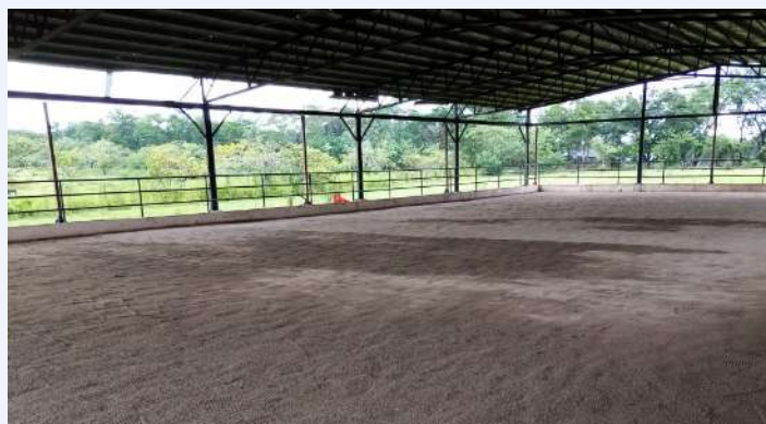
Acondicionamiento general de las capas de la pista de equinoterapia en Chilibre. Monto Invertido B/. 10,165.00
