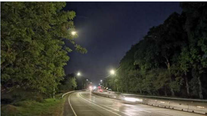
Mejoras en la iluminación vial – corredor norte
