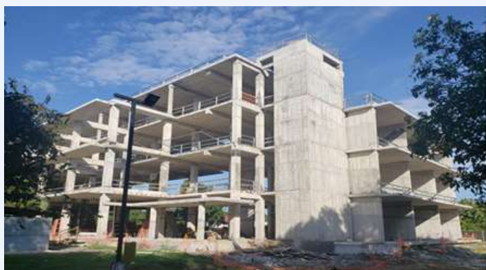
Edificio de Aulas, Centro Regional de Coclé
