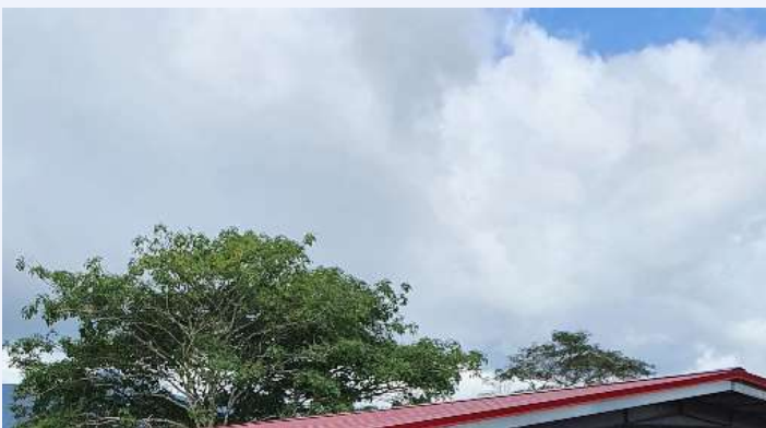
Proyectos 61083 y 61084 – Construcción de cocina comedor y cancha multiuso en el C.E.B.G. Mercedes Bustamante. Provincia de Coclé
