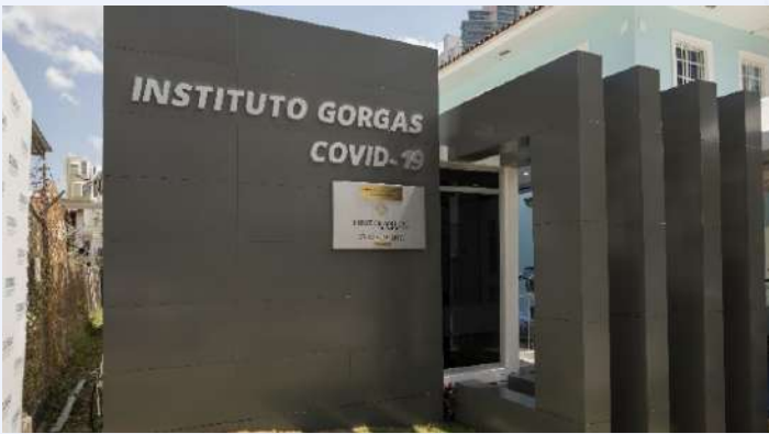
Vista exterior del Laboratorio COVID construido.
