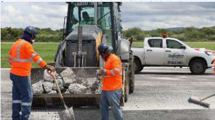
Trabajos de reparación de la pista 03R-21L.
