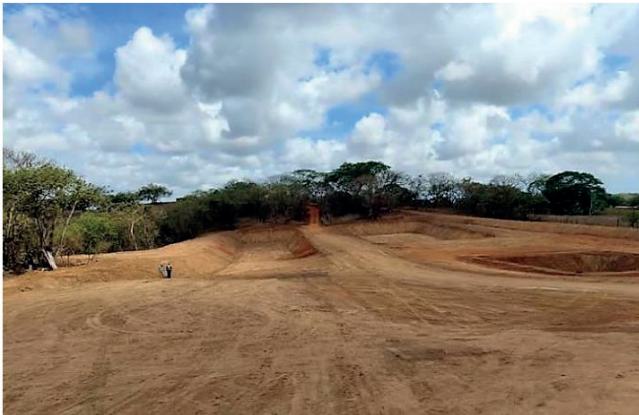
Adecuación y mejora de las vías internas del relleno.
