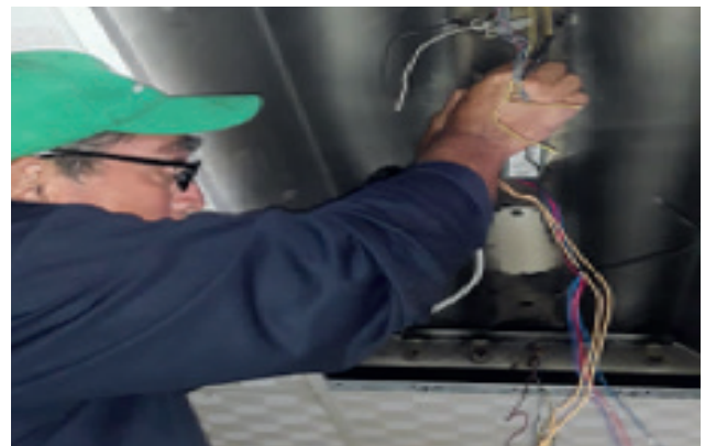
Cambio de Transformadores y tubos eléctricos en diferentes de departamentos
