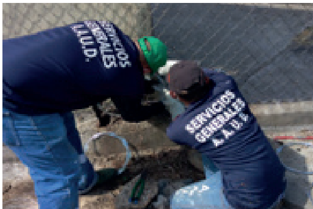
Reforzamos mallas de ciclón en el PH Multiplaza
