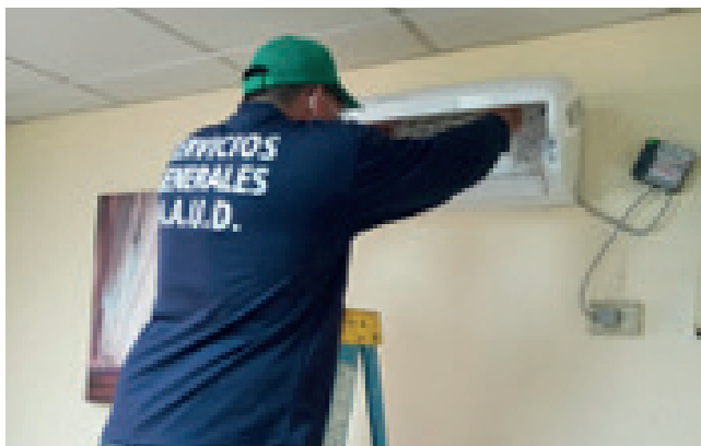
Limpeza de Aires Acondicionados.
