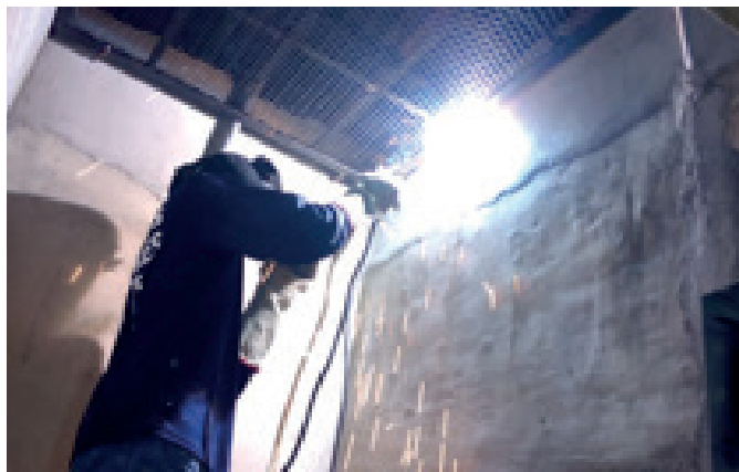
Confección e Instalación de Malla para reforzar la seguridad en el cuarto de sistemas en Zona D- Patacón
