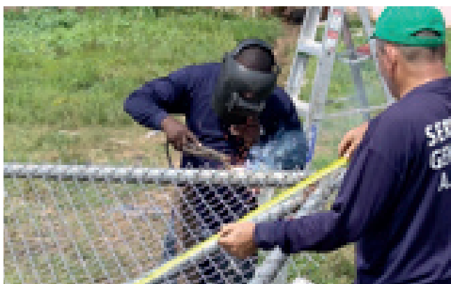
Reparación e instalación de una cerca en el área de Mañanitas que se vio afectada por una colisión de camión compactador de la AAUD.
