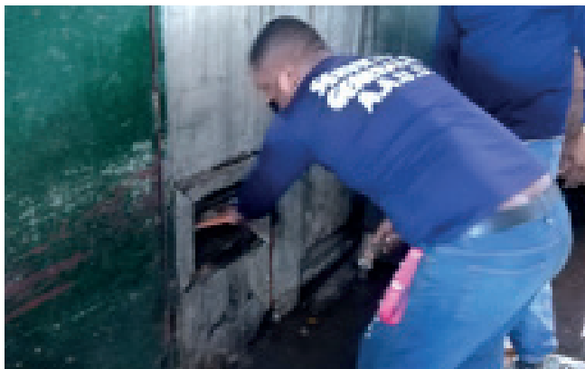
Cambio de tuberías en Zona A – Pacífico.
