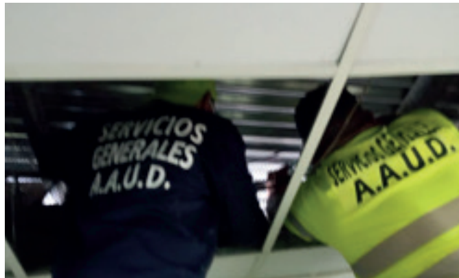
Colocación de malla expansiva en diferentes oficinas de Zona B-Carrasquilla para evitar que entren alimañas.
