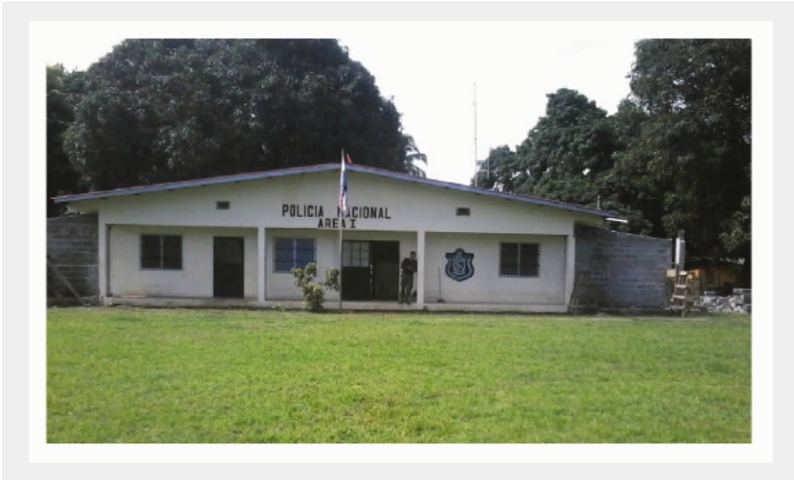
Diseño y construcción del puesto integral del Servicio Nacional Aeronaval, Servicio Nacional de Migración y la Autoridad Nacional del Ambiente, ubicado Los Buzos, en el corregimiento de Cambutal, distrito de Tonosí, en la provincia de Los Santos, valorado en 274 mil 437 dólares con 53 centésimos.
