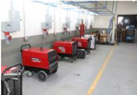
Taller de Soldadura - Chitré
