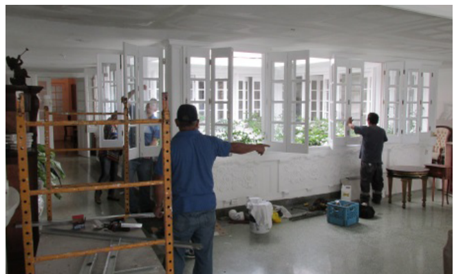
Trabajos de laqueo en ventanas de la residencia y cuartos internos, se pintaron los maseteros externo.
