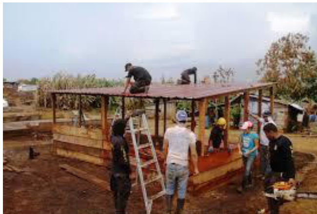
Reconstrucción de casa en la Comarca Madugandí.
