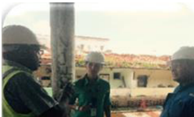
Apuntalamiento y Cerramiento del Edificio Maison Blanche.
