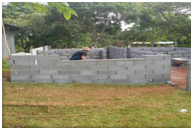
Trabajos de construcción de viviendas, de colaboradores.
