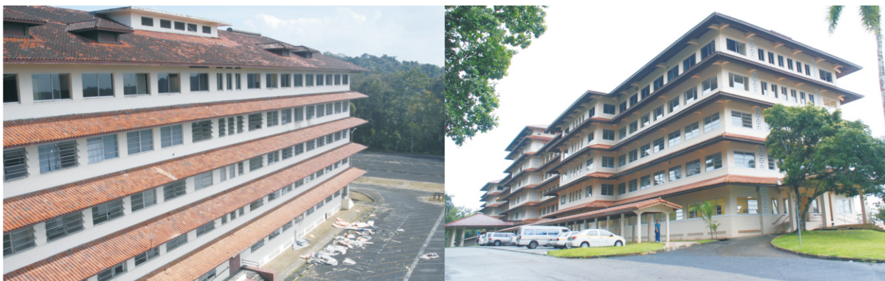
Vista del edificio N° 519 antes y después de la habilitación.
