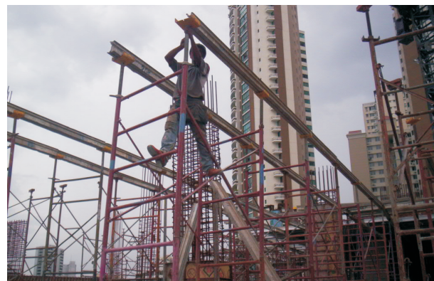
Inspecciones técnicas en obras de construcción en la provincia de Panamá.
