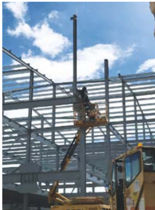
Colocación de estructuras metálicas en módulo A.
