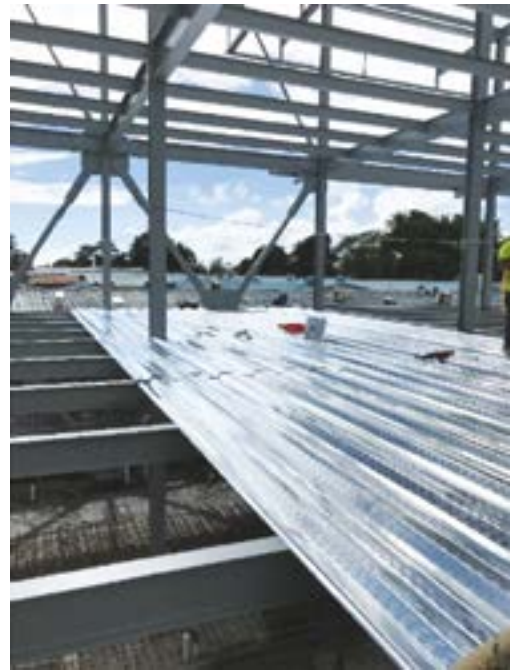
Colocación de Láminas de METALDECK.
