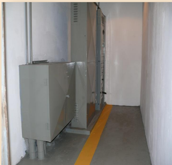
Modernización el sistema eléctrico del Edificio Principal
