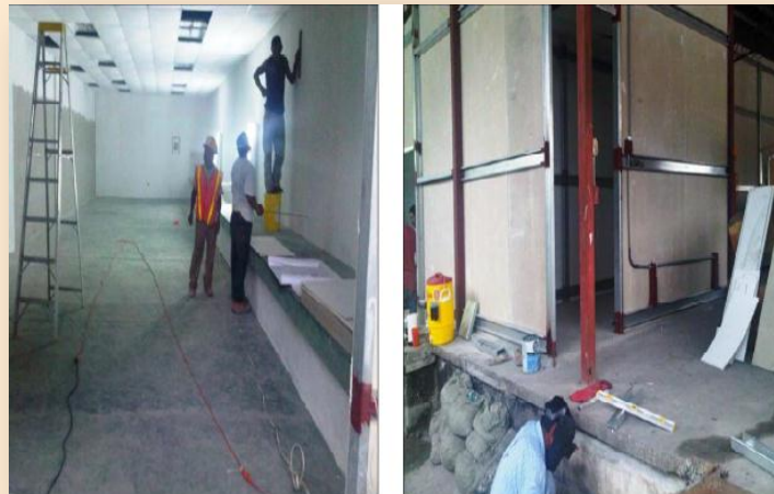
Habilitación del área de azotea según Contrato 004-2010, para la reubicación de una parte del Depósito del Almacén del ICGES.
