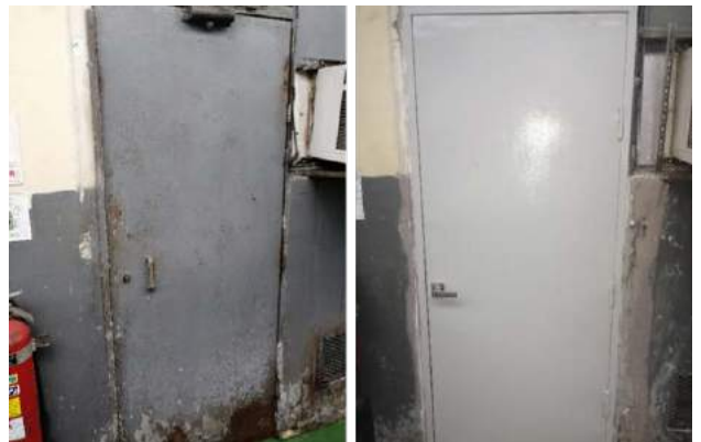
Suministro e instalación de 7 puertas de hierro para reemplazar la de los cuartos de los primates.
