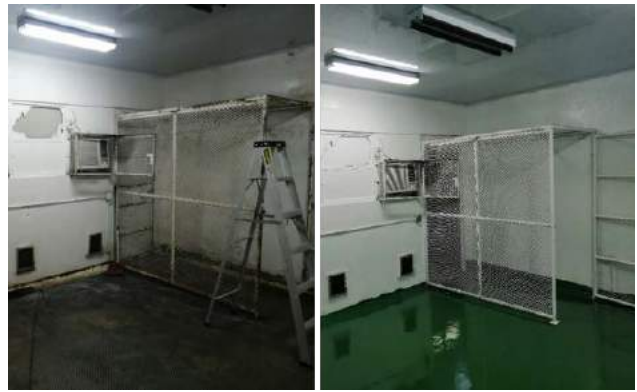
Aplicación de pintura epóxica en paredes y pintura de tráfico.
