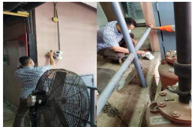
Calibración y reubicación del medidor de vapor.
