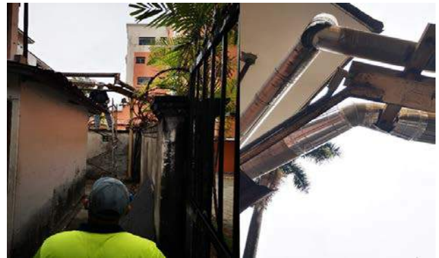
Reparación de fugas de vapor en la línea principal de suministro.
