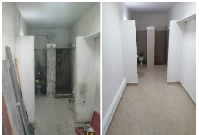
Mejoramiento al cuarto de vestidor del edificio del bioterio de primates.
