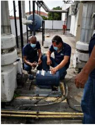
Reemplazo de motor de bomba de agua helada del chiller.
