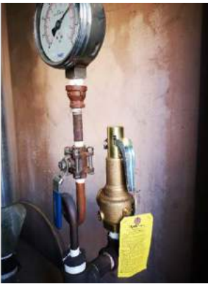
Cambio de válvula de seguridad y brida en el cabezal principal de vapor.
