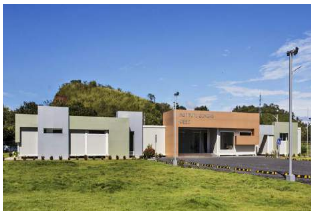
Fase I: Infraestructura.
