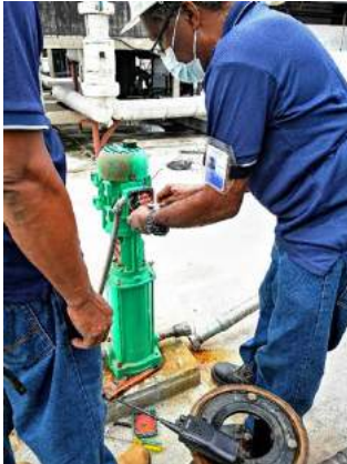
Reemplazo de bomba centrífuga.
