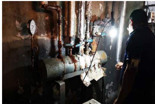
Reparación de fuga de vapor en el cabezal ubicado en el Bioterio de Primates.
