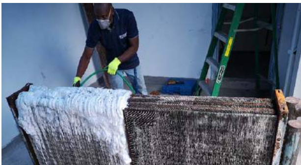
Mantenimiento de Coil de aire acondicionado (UMA).
