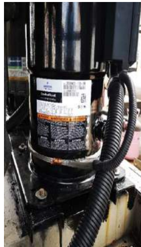
Suministro e instalación de un compresor de 25 HP en el chiller No. 2.
