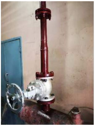
Cambio de válvula de seguridad y brida en el cabezal principal de vapor.
