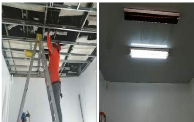
Instalación de cielo raso tipo PVC.
