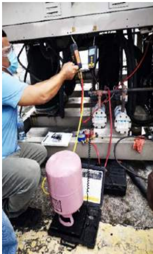
Suministro e instalación de un compresor de 25 HP en el chiller No. 2.
