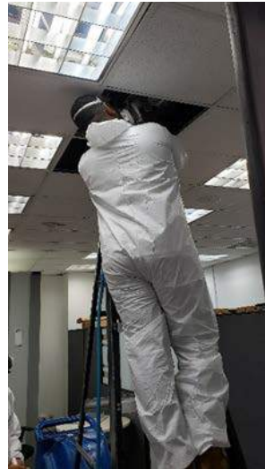
Mantenimiento de limpieza interna de ductos de aire acondicionado en el CRECS.
