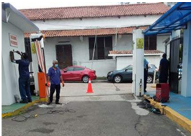
Ajuste de articulado, balance, ajuste de poste de fotocelda.
