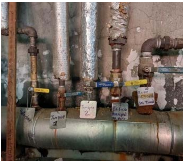
Adecuación de sistema de caldera al autoclave de descontaminación.
