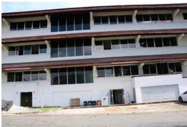
Edificio 233 en Ciudad del Saber, en donde se habilitarán los laboratorios de Investigación del ICGES.
