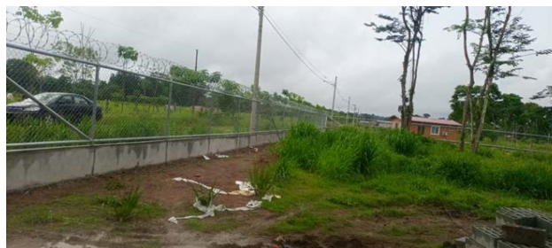
Terreno de 2600 mts2, delimitado por la cerca perimetral.
