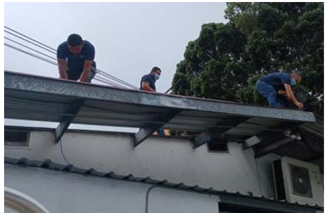
Reemplazo de techo en Almacén.
