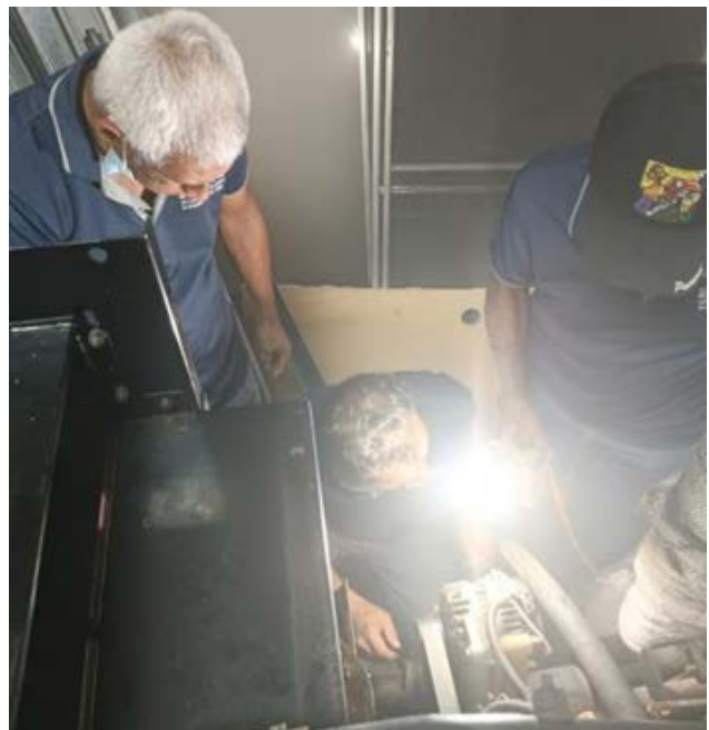
Reemplazo de bomba de agua del Radiador de la Planta eléctrica.
