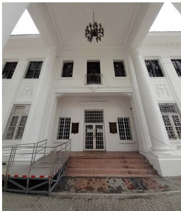
Imágenes generales donde se puede observar los trabajos de pintura realizados en el edificio patrimonial.
