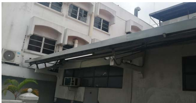
Trabajos realizados en el techo del edificio de Bioterio de Primates.
