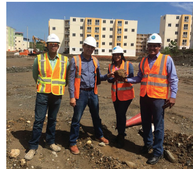
VISITA EN SITIO CON PLANOS PARA LA CONSTRUCCION DE LA FUTURA SEDE DE UDELAS COLÓN
