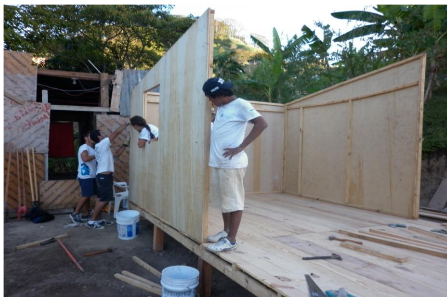
Construcción de casas en la comunidad de Guna Nega
