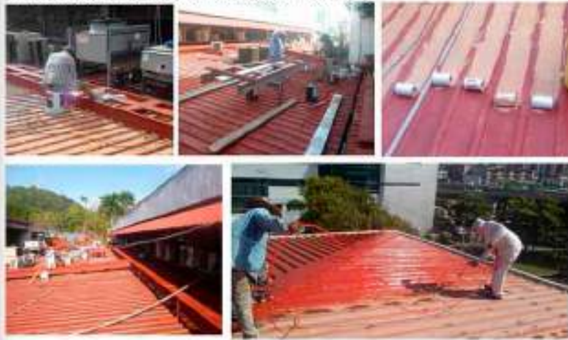
Mejoras de techos, edificio del Palacio Justo Arosemena
