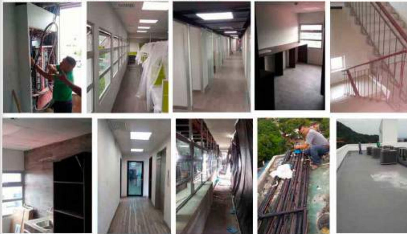
Adecuación de los nueve (9) pisos de la torre del Palacio Justo Arosemena
