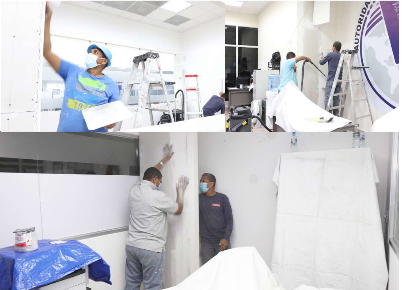
Equipo de Servicios Generales, encargados de mantener el buen estado de las estructuras de Apap.
