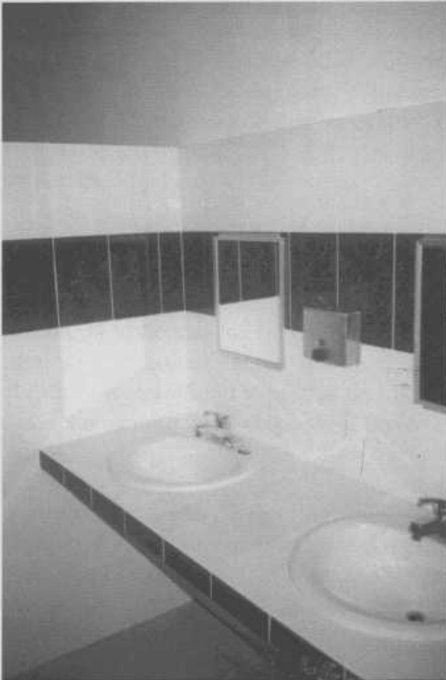
Instalación de llaves de palanca en los lavamanos, extensión de Antón, provincia de Coeló.
