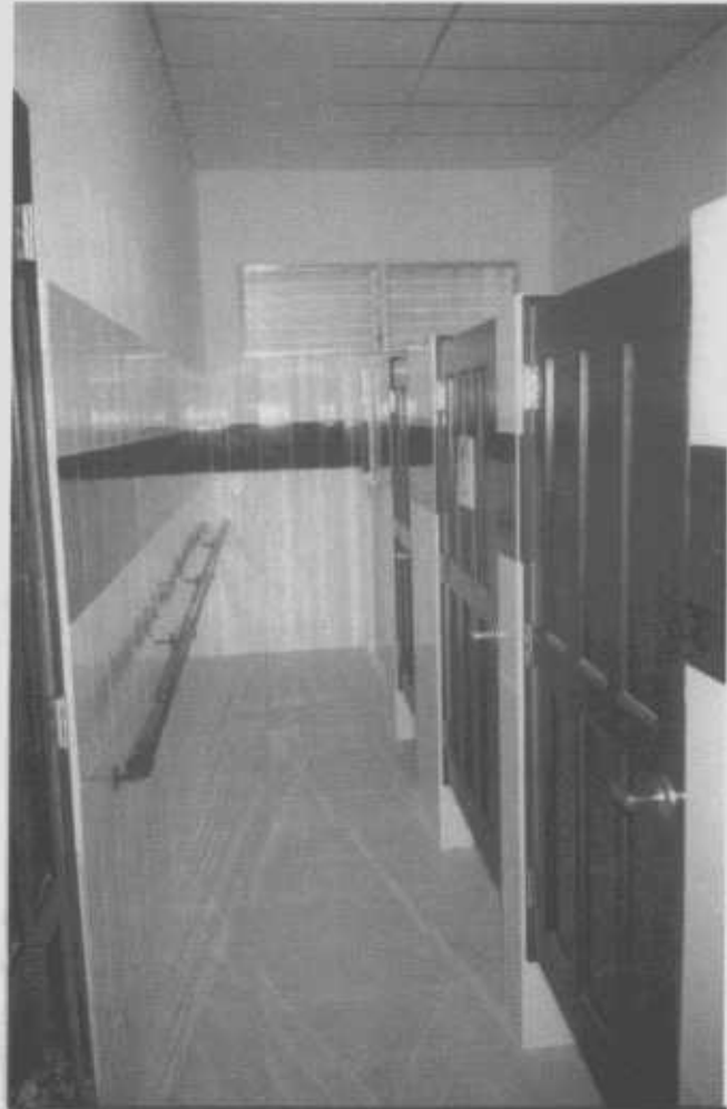
Barras de asimiento y señalización, extensión de Antón, provincia de Coeló.
