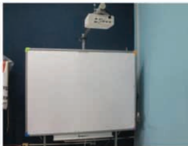
Instalación de tablero interactivo
