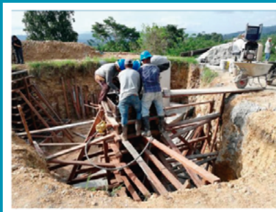
Sitio en construcción en la comunidad de Agua Buena
