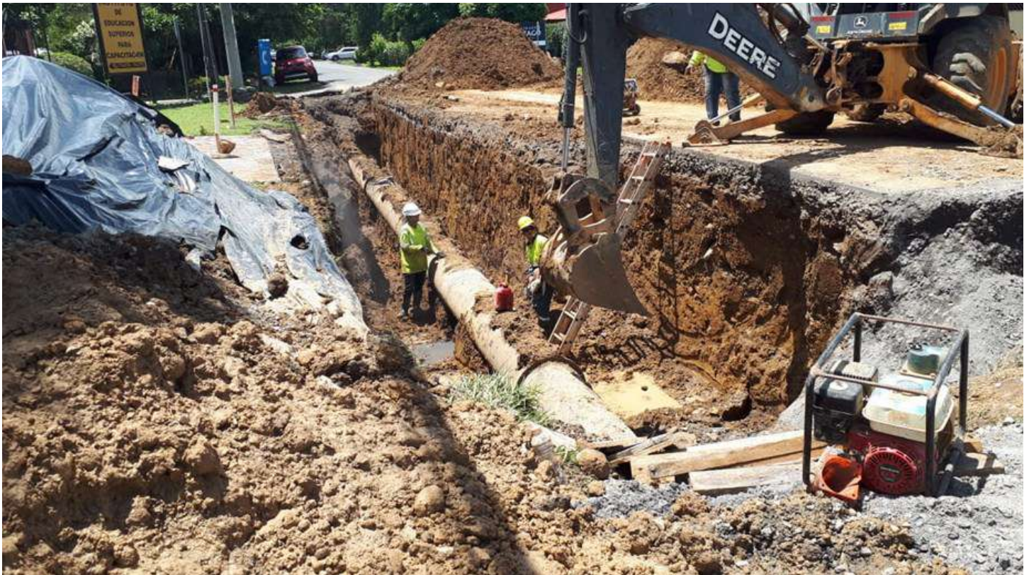
Instalación de nuevas líneas de conducción en David.
