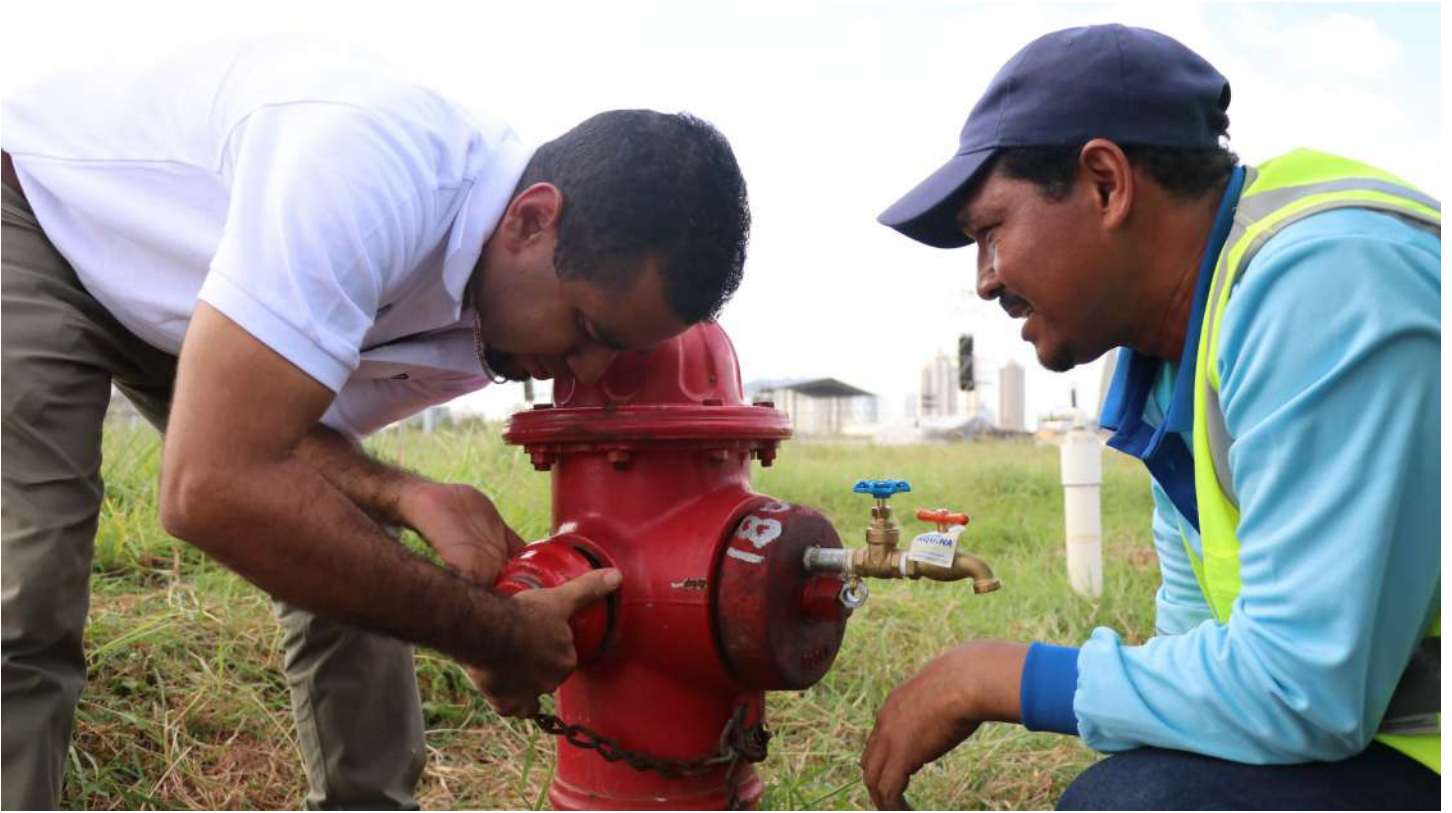
Cambio y mantenimiento de hidrantes, por parte de personal técnico del IDAAN.
