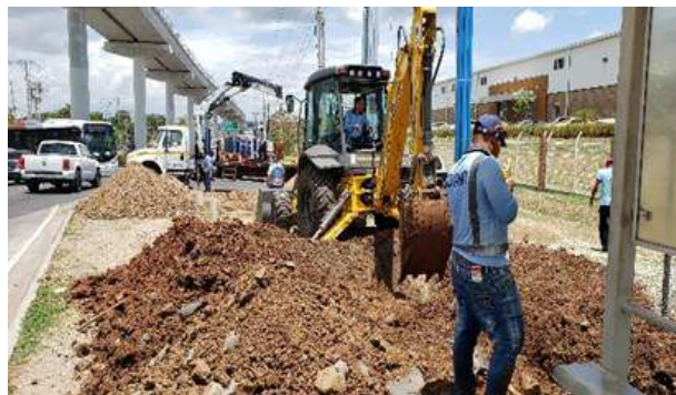
Culminación y puesta en operación de nueva estación de bombeo de Los Jardines de Pacora, 24 de diciembre.
