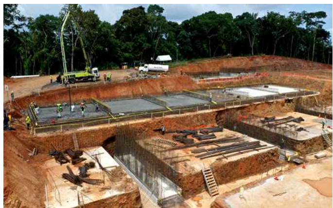
Construcción de la PTAP de Howard ( 40 a 60
