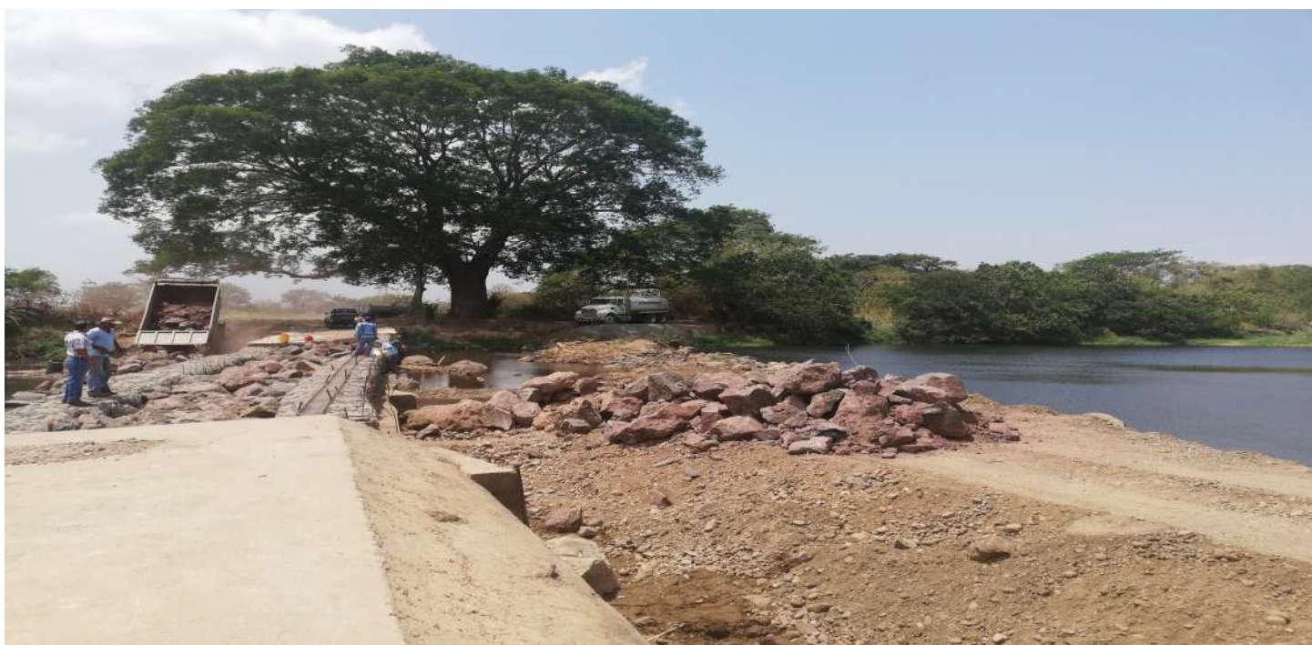
Represamiento del río Pocrí en Natá, el cual abastece a la toma de agua cruda de la planta potabilizadora de Natá.
