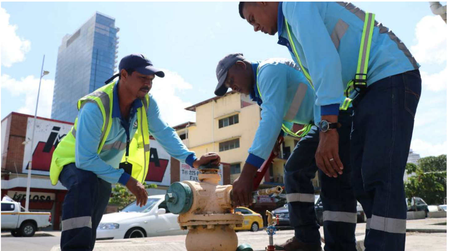
Cambio y mantenimiento de hidrantes, por parte de personal técnico del IDAAN.
