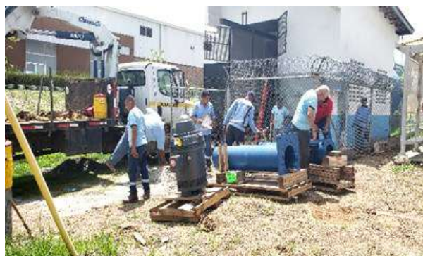
Instalación de cuatro nuevas unidades de bombeo de 75 HP, 700 GPM. Funcionando dos simultáneamente en estación de bombeo ciudad del Lago.
