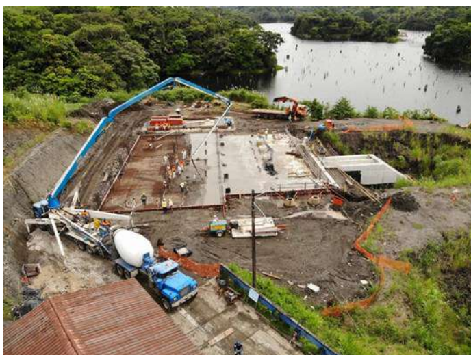
Vaciado de concreto en la losa del edificio de la toma de agua cruda, Sabanitas II.
