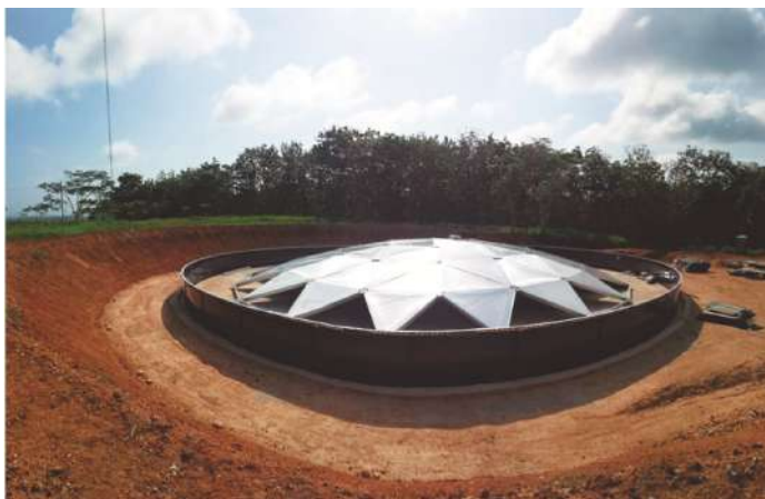
Planta potabilizadora de Villa Darién.
