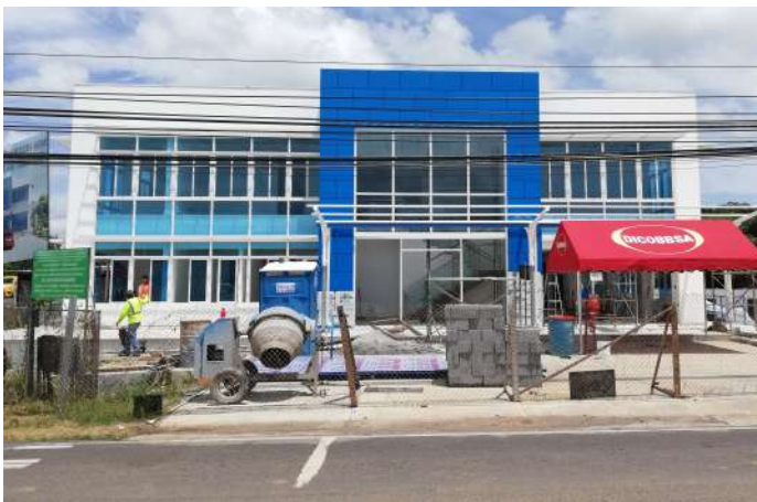
La construcción del edificio sede de la Regional de Veraguas registra un 95% de avance.
