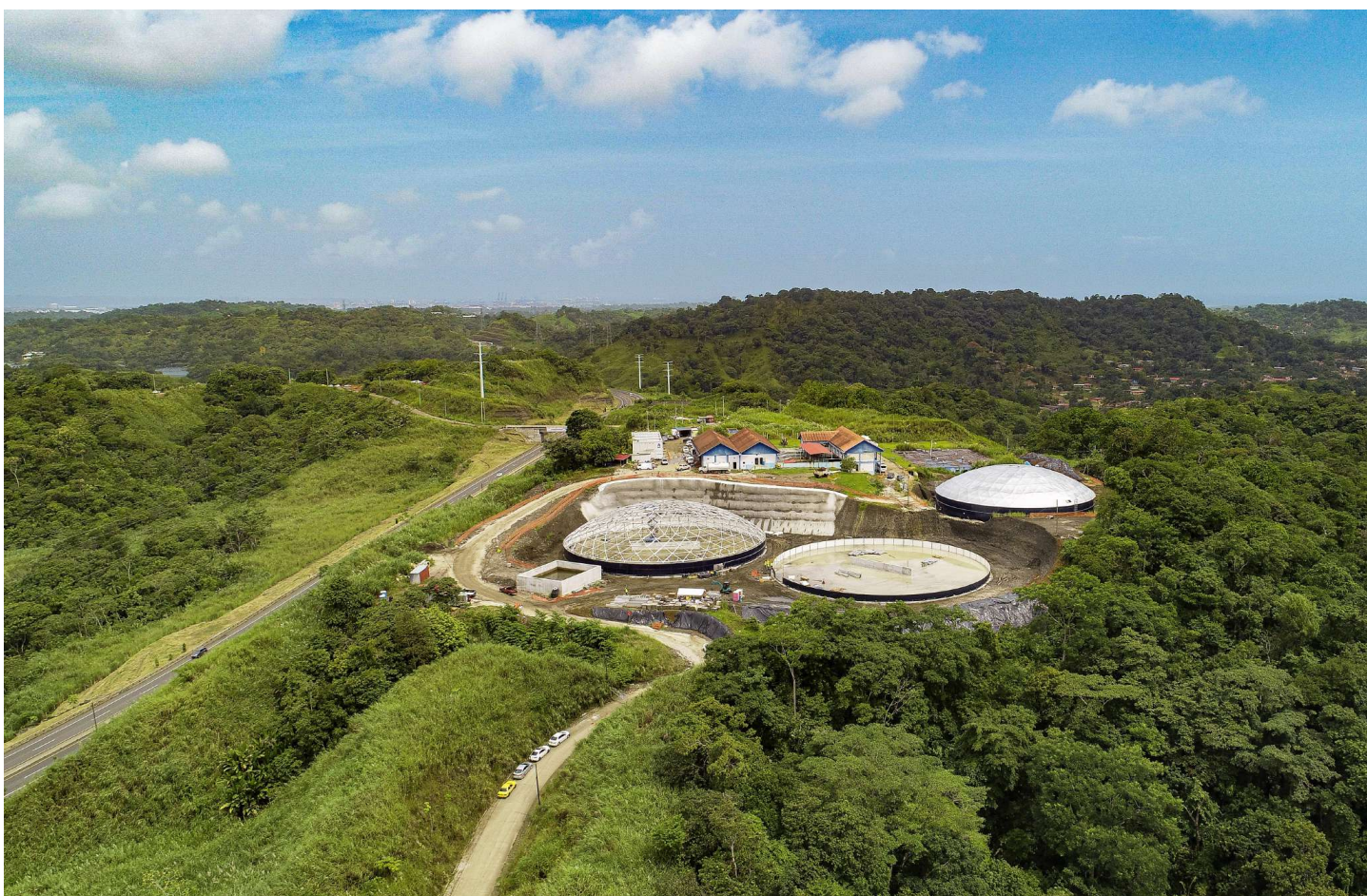
Tanques de Almacenamiento de Sabanitas II de 10MGD y reemplazo del tanque de almacenamiento de Sabanitas I.
