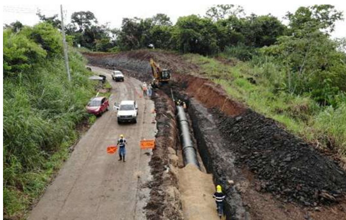
Instalación de Tuberías de 72" HD PTAP de Gamboa.
