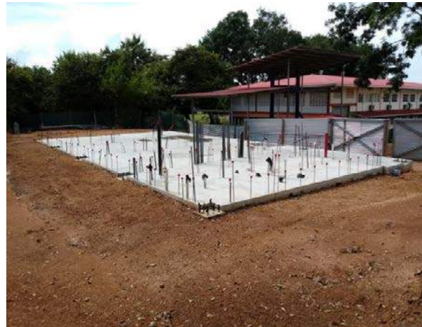
Construcción de Taller en el Centro Regional de Azuero
