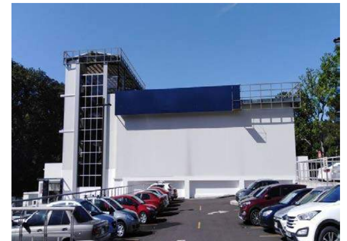
Construcción del Complejo de Investigación, Edificio del Laboratorio de Estructura, Campus Dr. Víctor Levi Saso
