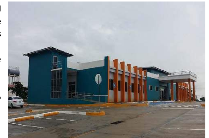
Construcción del Edificio de Aula en el Centro Regional de Panamá Oeste
