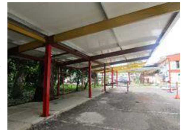
Construcción de Cobertizo en el Edificio Administrativo, Sede Panamá
