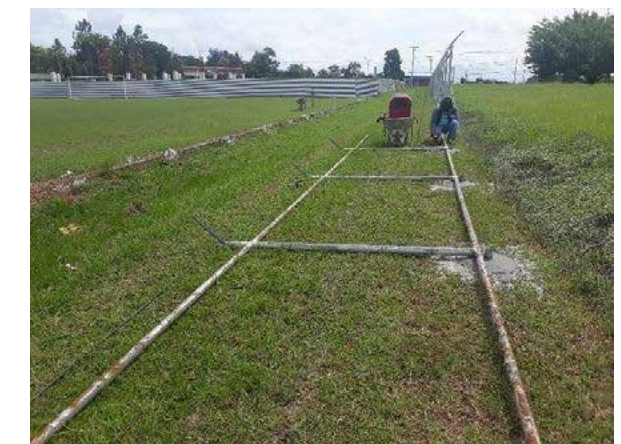
Extensión de la Cerca Perimetral, Centro Regional de Veraguas
