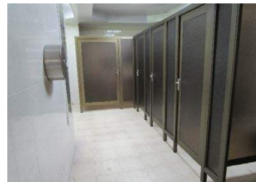
Remodelación de Baño en el Centro Regional de Chiriquí
