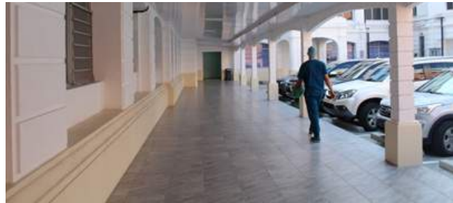
Remodelación del Pasillo – Corredor del Edificio Elefante Blanco
