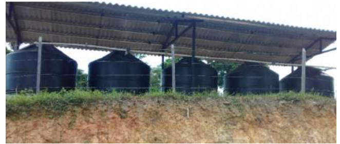
Inspección de proyecto de construcción de Mejoras al acueducto de Calobévara, Santa Fé (abril del 2019).
