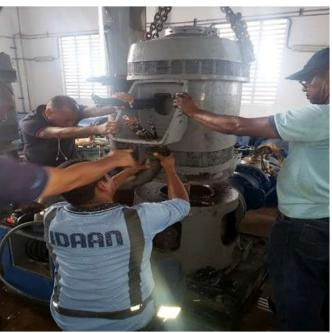
Proceso de Instalación de motor de 250HP en la Planta Centenario.
