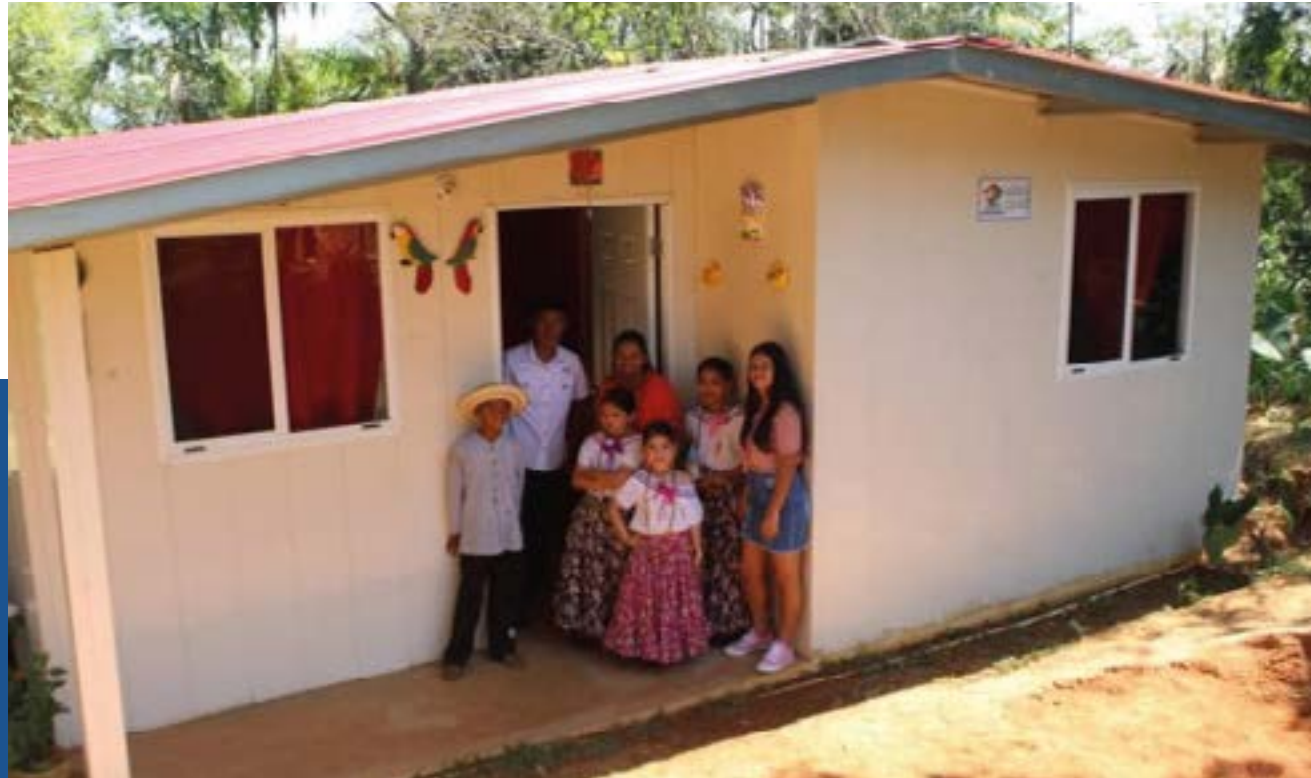
Entrega de 215 viviendas en el distrito de Las Minas
