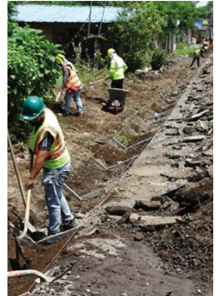
Construcción de Cunetas, Kilómetro 0 en San Andrés, Proyecto carretero de circunvalación.
