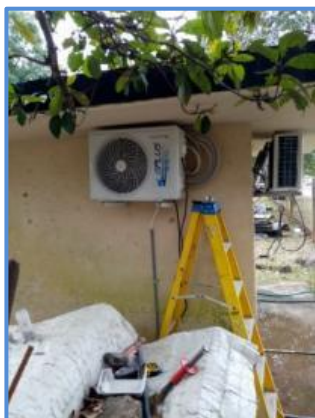
Instalación de equipo de aires acondicionados en la Estación de Monitoreo en la provincia de Chiriquí.
