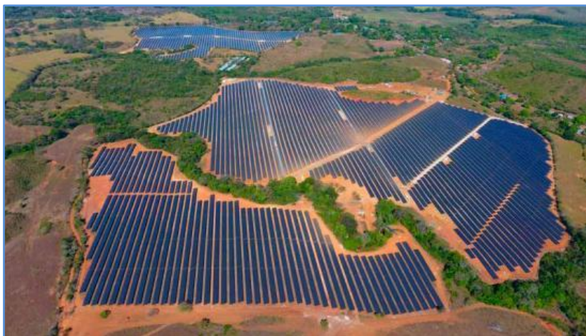
Mendoza Solar 3 MW
