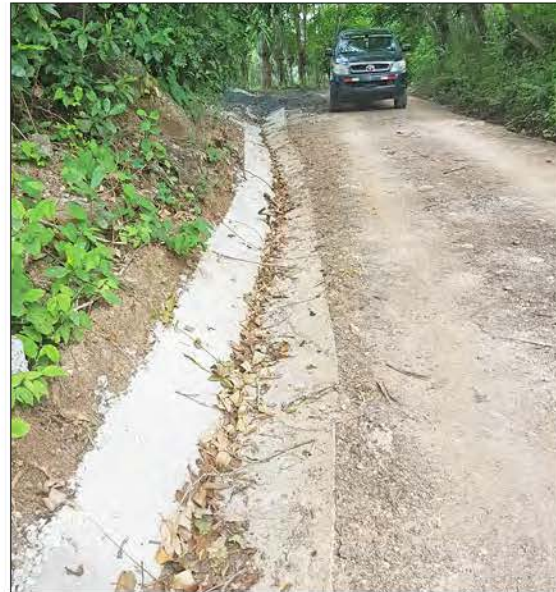
Los Santos, distrito Pocrí, corregimiento de Lajamina, construcción de cunetas pavimentadas.
