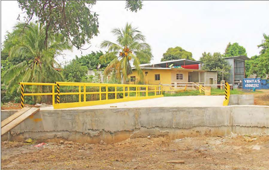
Puente Juan Gómez, calle Primera de Damasco, distrito de Chitré, provincia de Herrera.
