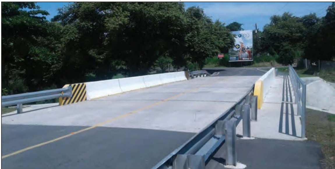
Puente de dos vías sobre el río Poro-Poro
