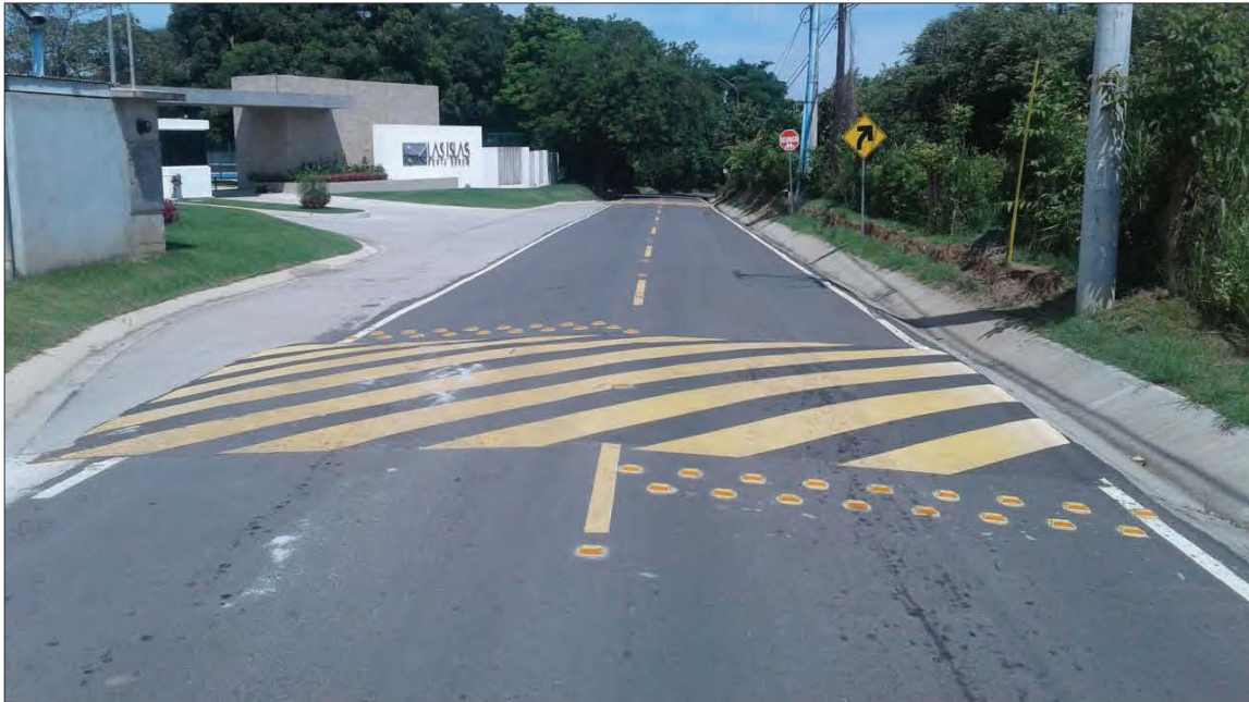
Vía CPA-Punta Barco Viejo en su estado actual
