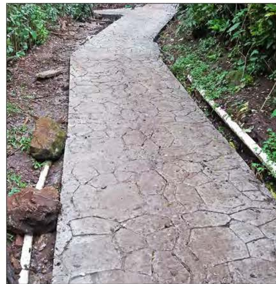
Proyecto de rehabilitación de carretera y construcción de drenaje en Las Huacas, distrito de Las Minas, provincia de Herrera.
