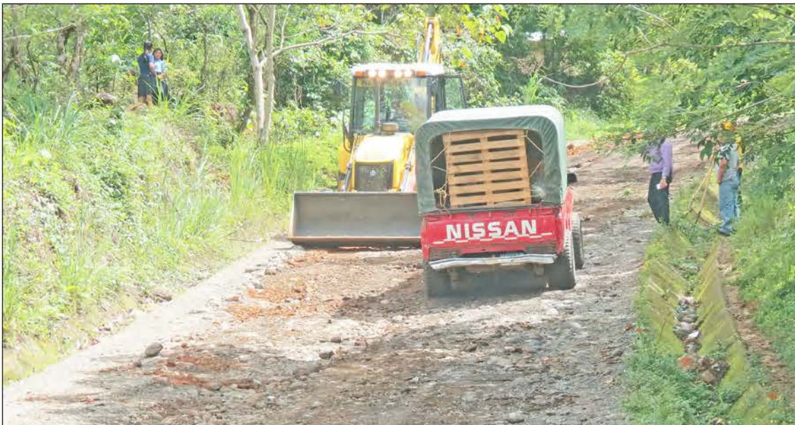
Mejoras en los caminos ubicados en Cerro Iglesias, corregimiento del distrito de Nole Duima en la Comarca Ngäbe-Buglé.
