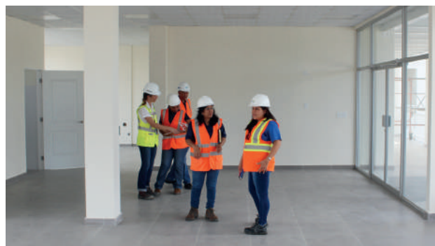
Vista parcial de la Construcción del Proyecto Colón 5,000.
