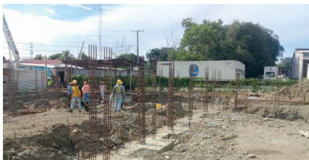
Vista parcial de la Construcción del Centro Reintegra de Bocas del Toro.
