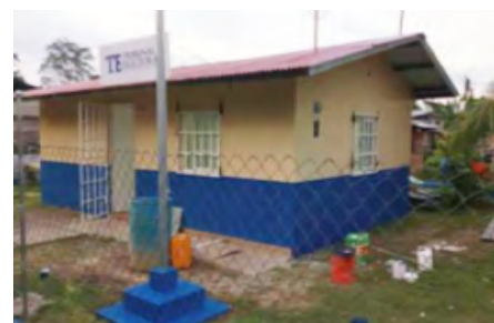
Reparación oficina de Sambú Monto B/. 18,994 Fecha de entrega: nov. 2020
