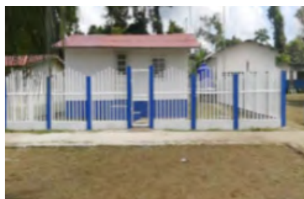
Reparación oficina de Unión Chocó Monto B/. 20,000 Fecha de entrega: nov. 2020
