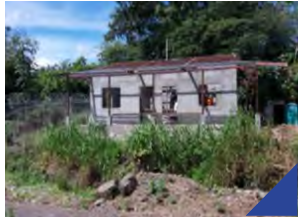
Vistas de la construcción de la oficina.
