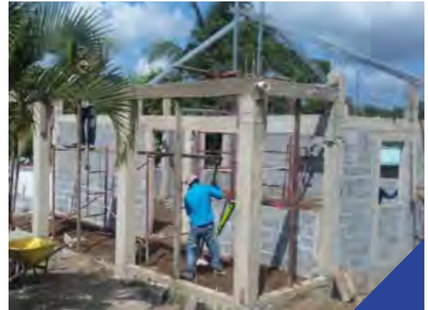
Vistas de la construcción de la oficina.
