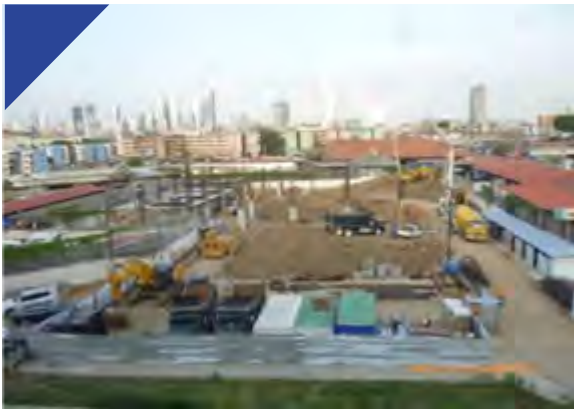
Vistas del inicio de la construcción del edificio.
