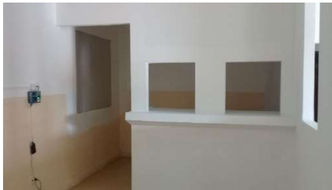
Construcción de oficina para la sección de caja Dirección provincial de Darién
