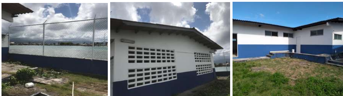
Mantenimiento de todas las estructuras Dirección comarcal y Centro Estudiantil de Guna Yala
